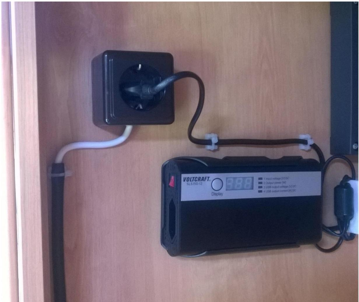
Wenn das Wohnmobil am Stromnetz angeschlossen ist, diese Steckdose (im Kleiderschrank) benutzen. Diese ist nur für die Xbox, für Verbraucher, die zu viel Strom ziehen ist diese nicht ausgelegt, Die Sicherung würde durchbrennen und dann hat die Steckdose keinen Strom mehr.
